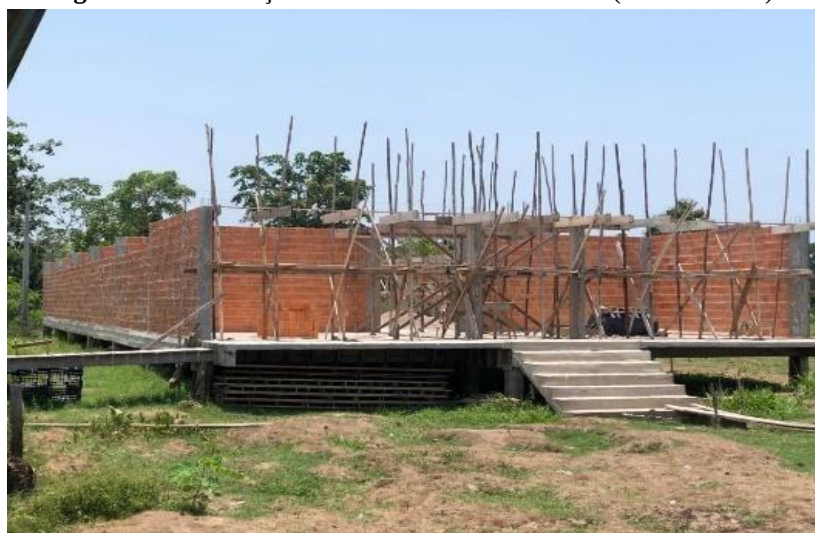
Fotografia 8- Construção da nova escola em alvenaria (escola núcleo)
