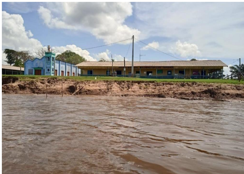
Fotografia 2: Frente da escola São Sebastião do Boto
