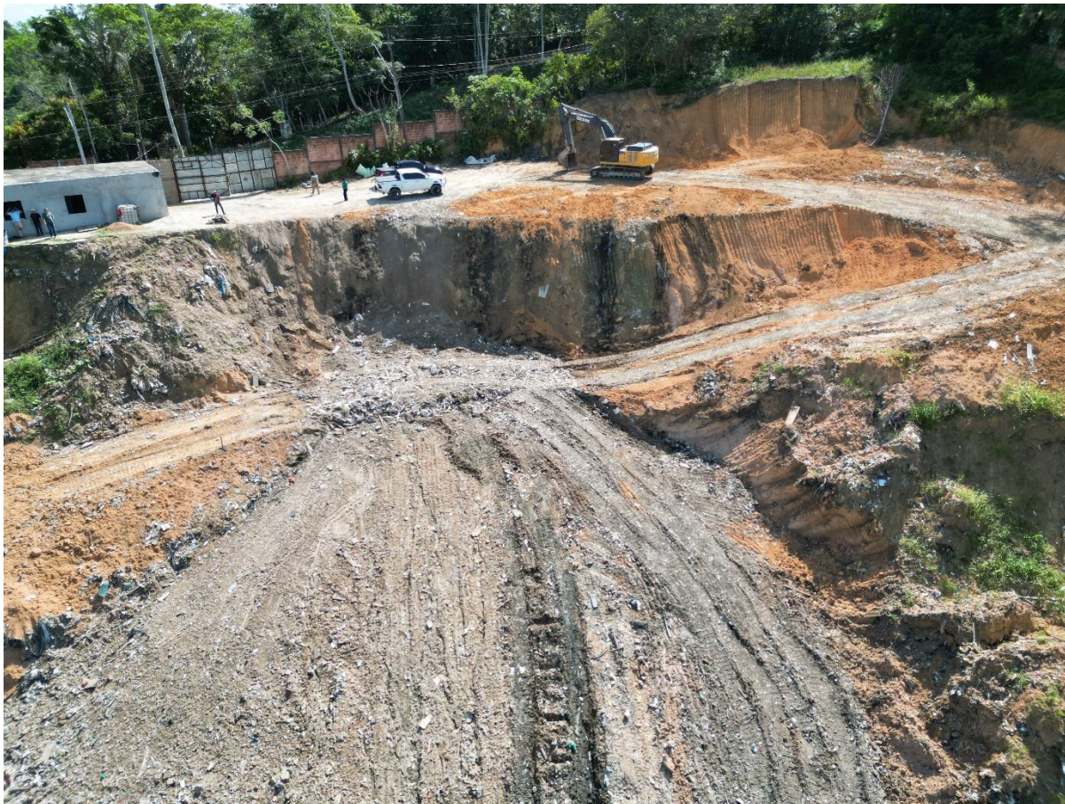
Figura 20 Aterro de Inerte, no bairro Cidade de Deus. Fonte: Alves, Manoela, 2024.
