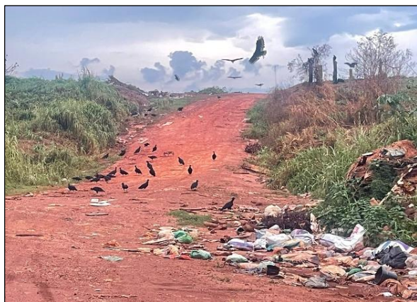
Figura 12 - Entrada do lixão sem portaria. Fonte: Autor (2025).
