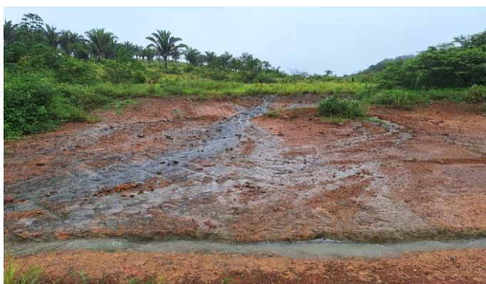
Figura 18 - Escoamento de efluentes no fundo do terreno do lixão. Fonte: Autor (2026).
