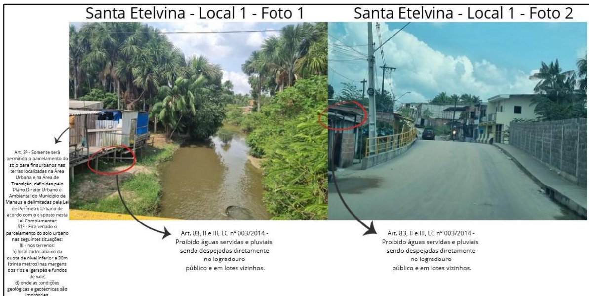
Figura 40. Rua E: primeiro ponto - precariedades.
