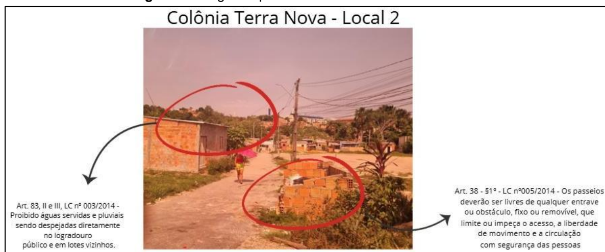
Figura 48. Segundo ponto do bairro Colônia Terra Nova.
