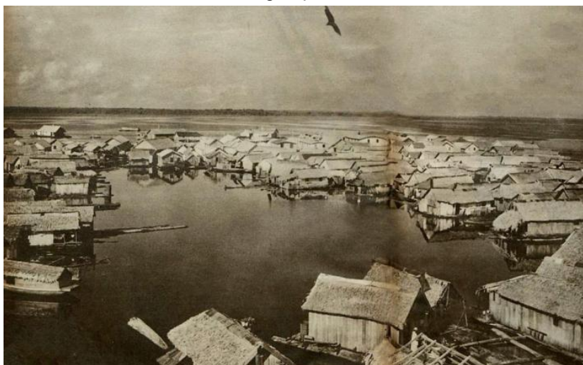
Figura 8. Casas construídas sobre os igarapés conhecidas como Cidade Flutuante.
