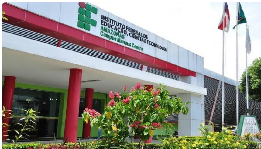
Figura 4: Instituto Federal do Amazonas, campus Manaus Centro
