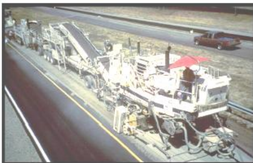
Figura 9 - Trem de reciclagem usado na FDR.
