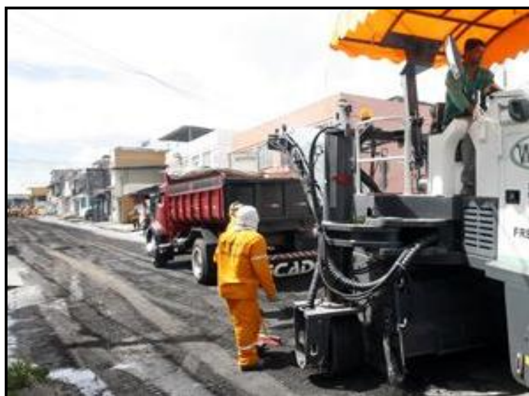
Figura 5 - Procedimento de fresagem de pavimento no conjunto Manauense em Manaus/AM. Fonte: SEMINF/PMM.
