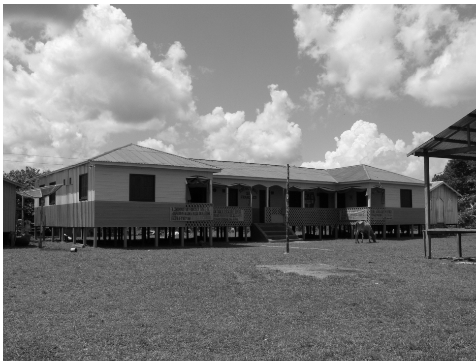
Figura 7 – Escola municipal São Francisco.
