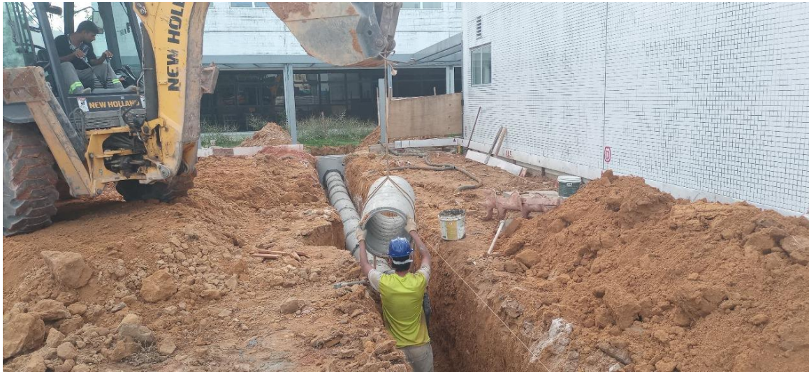
Figura 5: Assentamento de tubulação de esgoto.
