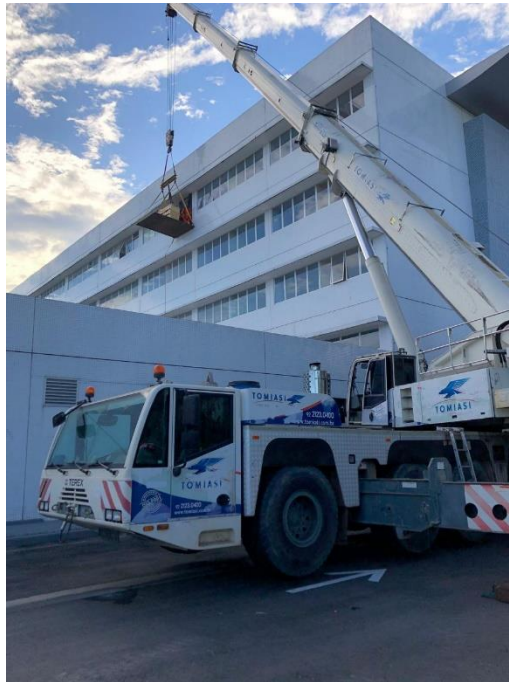
Figura 2 – Içamento de equipamentos no HEMOAM Hospital.
