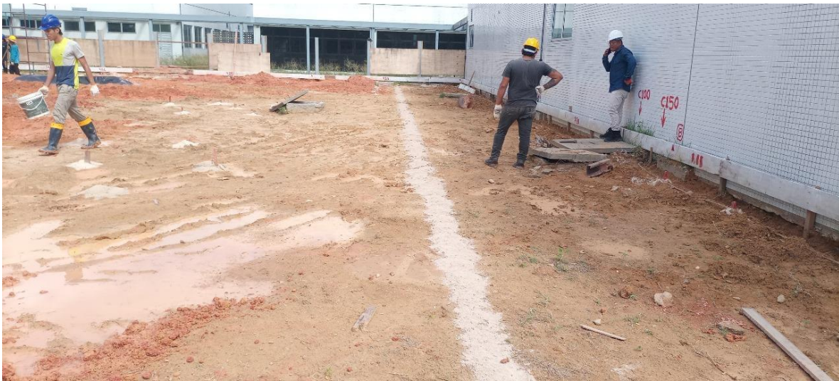
Figura 6: Reaterro da tubulação de esgoto.
