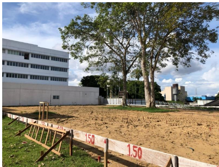
Figura 4: Canteiro de obras do bloco de laboratórios.
