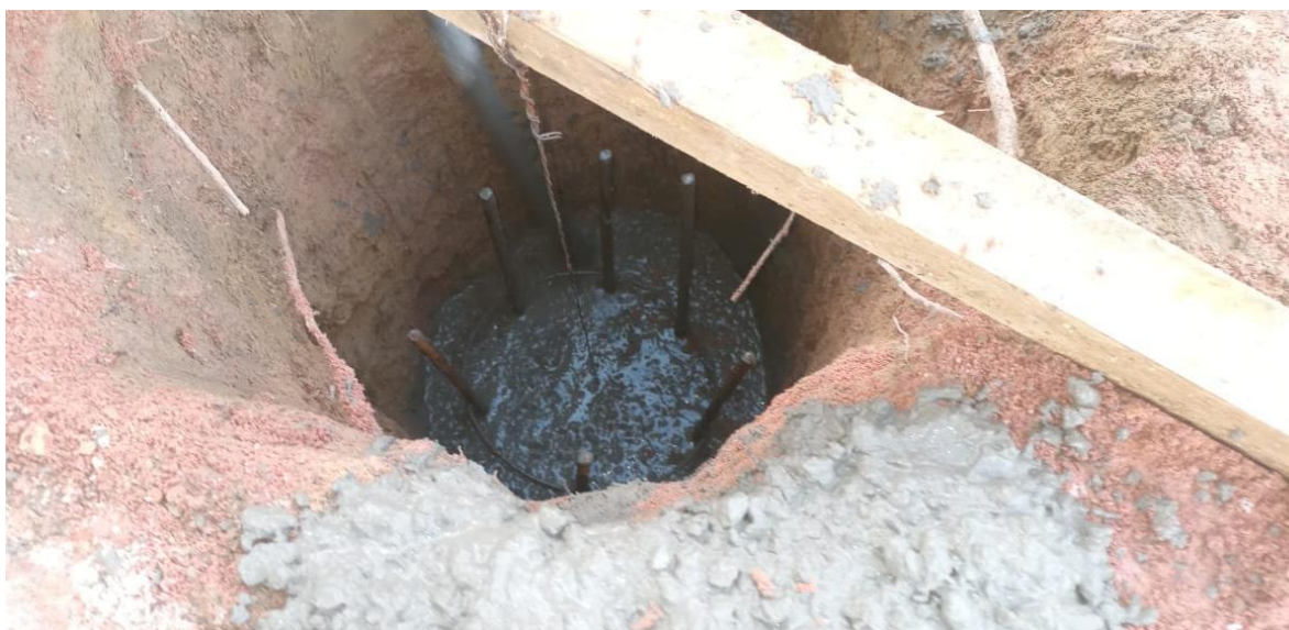
Figura 7: Concretagem de estacas.
