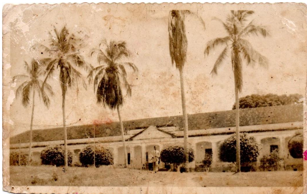
Figura 5 – Vista frontal do Hospital-Colônia Belisário Penna (1930-1967).
