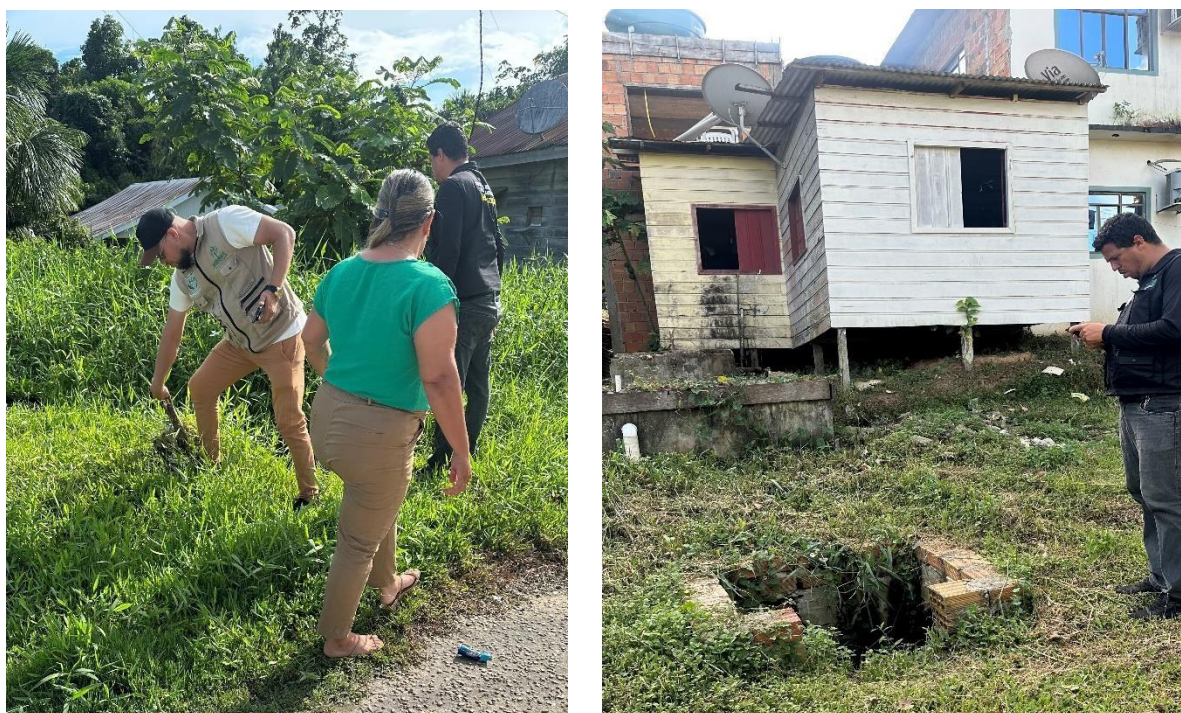
Imagem 02: Vistoria E Monitoramento A Bueiros Abertos Ou Obstruídos No Bairro De Coimbra
