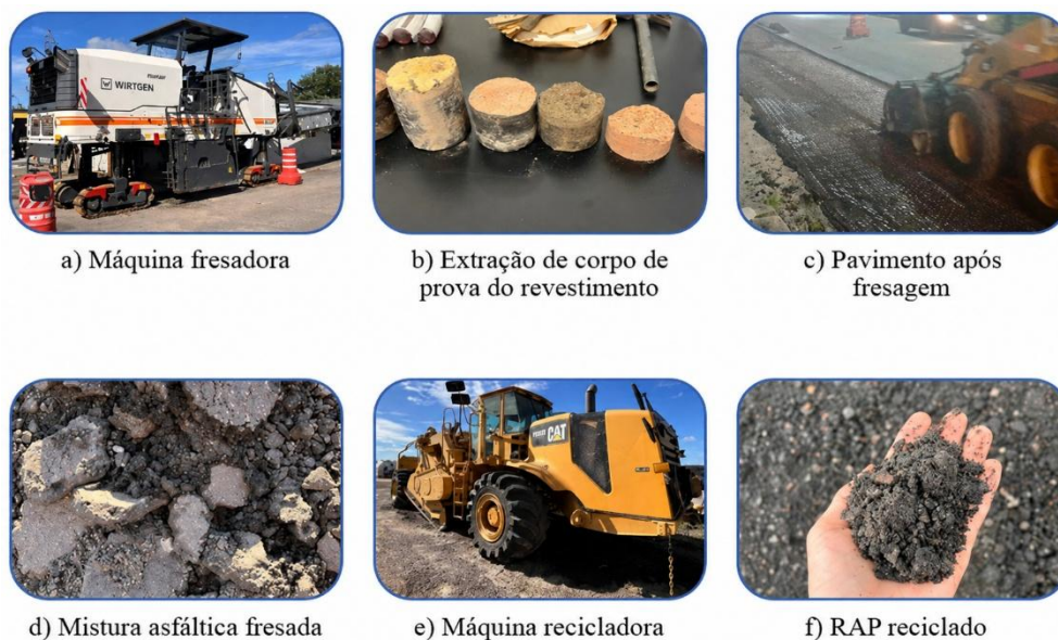
Figura 3.1 - Processo de obtenção do RAP
