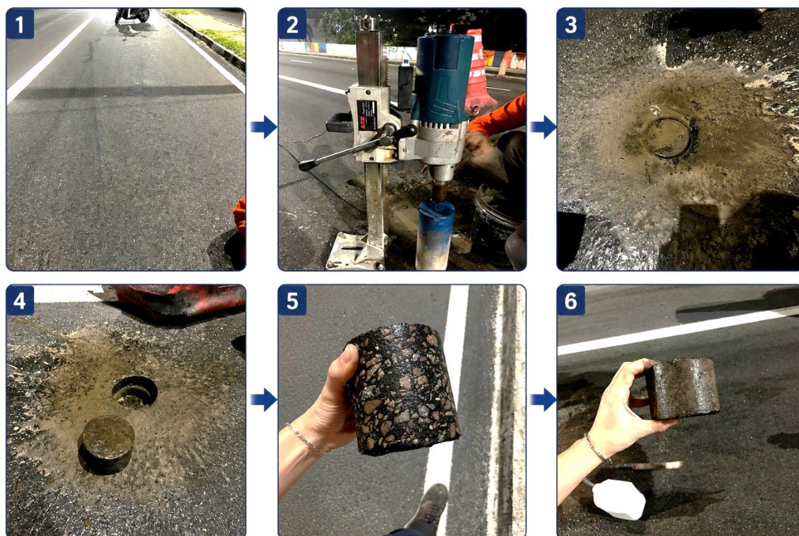
Figura 3.10 - Extração dos corpos de prova do campo
