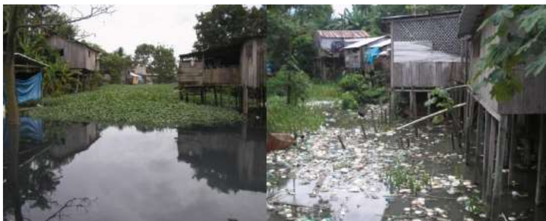
Figura 24 - Situação do bairro Dom Pedro durante a cheia
