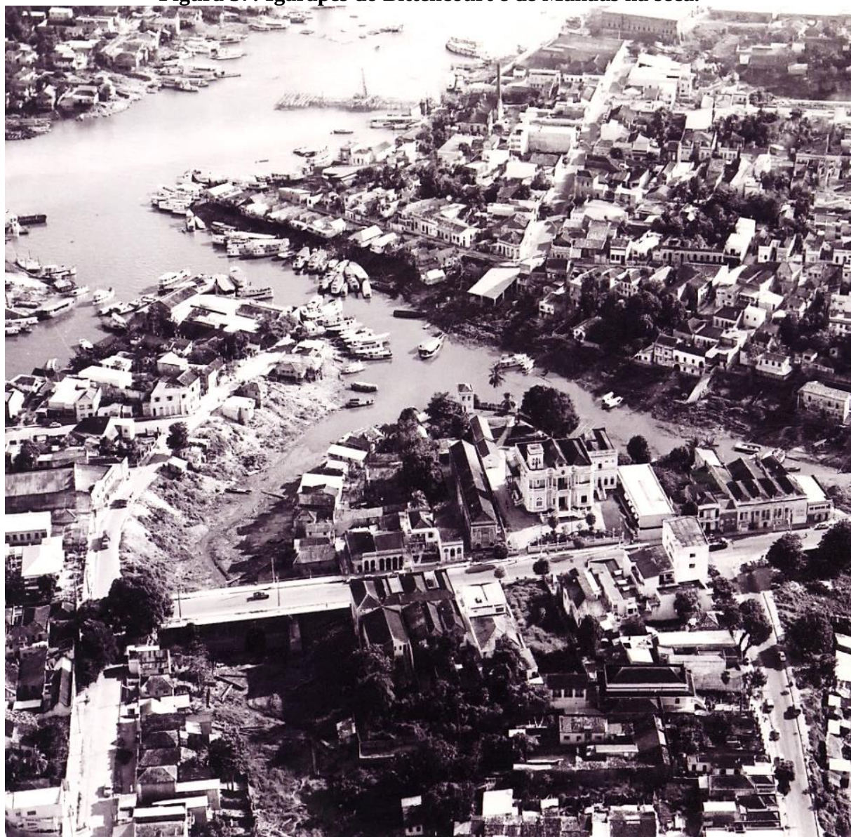
Figura 37: Igarapés do Bittencourt e de Manaus na seca.
