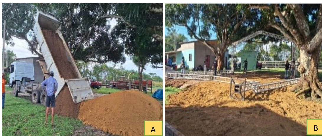
Figura13 – Chegada do aterro para o nivelamento do local do evento(A), aterro espalhado no local para exposição das tendas, mesas e cadeiras(B).
