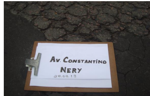
Figura 22 - Pavimento trincado.
