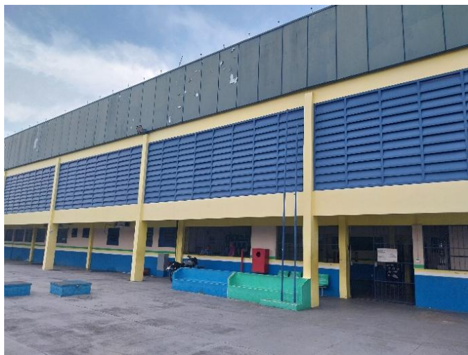
Figura 2 - Fachada do prédio escolar: onde a pesquisa encontrou seu lugar
