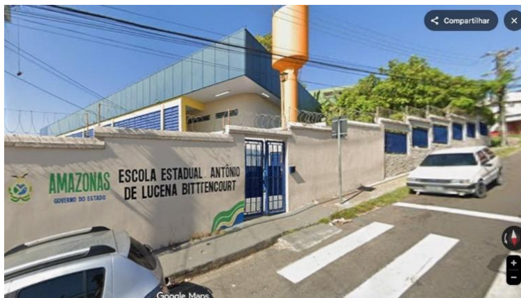
Figura 1 - Muro da Escola Estadual Antônio de Lucena Bittencourt: o território da pesquisa
