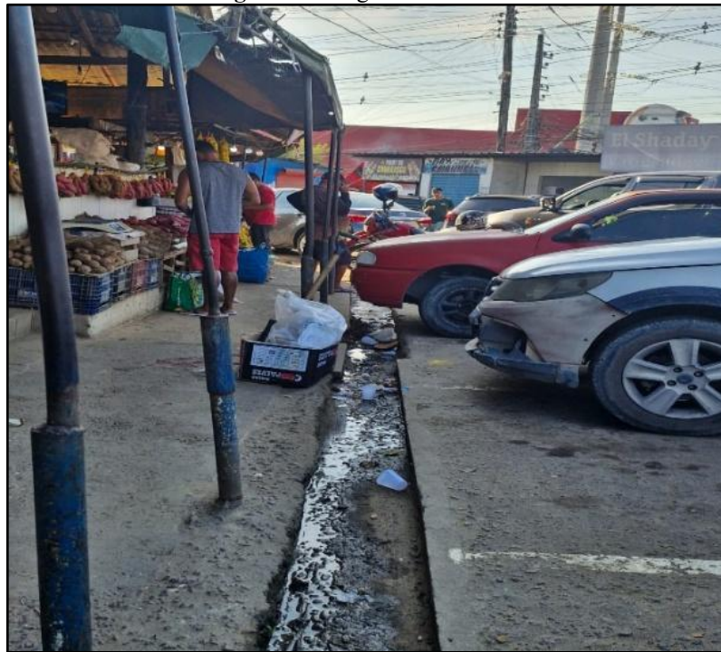
Figura 34 - Esgoto à céu aberto
