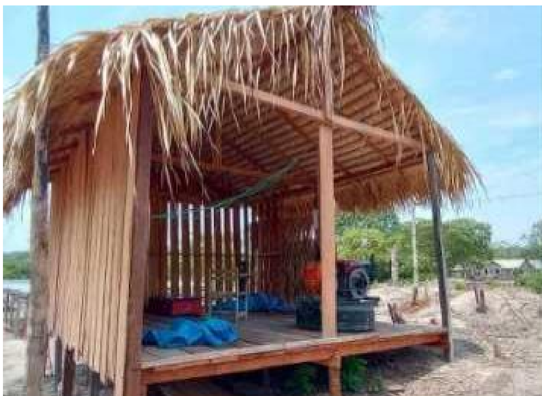
Figura 27: Gerador de luz
