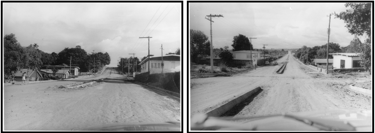
Figura 15 – À esquerda: construção da pavimentação da Ladeira da rua Paraíba; à direita: o Baixo Adrianópolis – final da déc. de 60.
