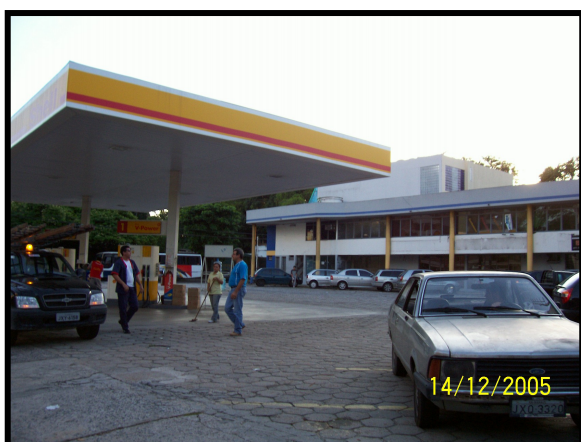
Figura 17 – Antigo restaurante “Chapéu de Palha”
