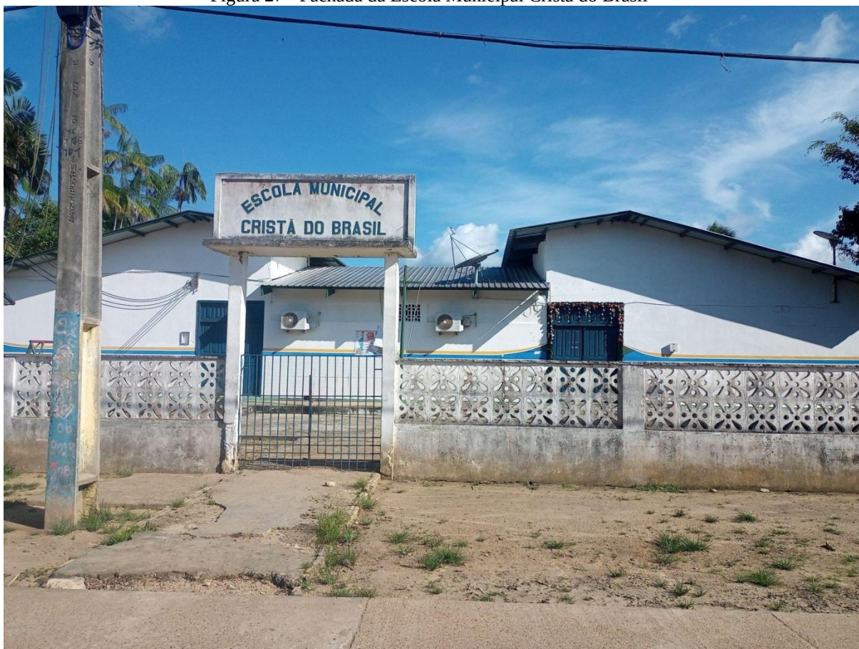
Figura 27 - Fachada da Escola Municipal Cristã do Brasil
