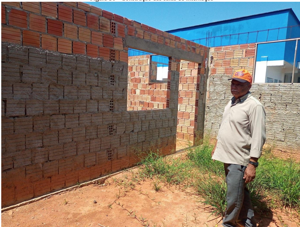
Figura 30 - Construção das salas de internação
