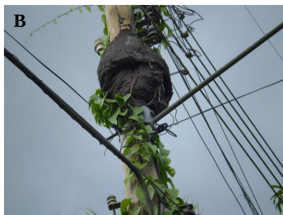
Figura 5 - Base de poste cercada por vegetação rasteira (A) e parte superior com ninho de cupim (B).
