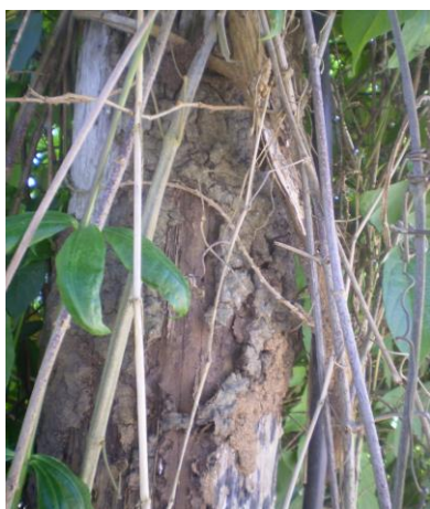
Fig. 6 - Vegetação em contato com o poste. Fonte: Oliveira, P.V.C., 2008.
