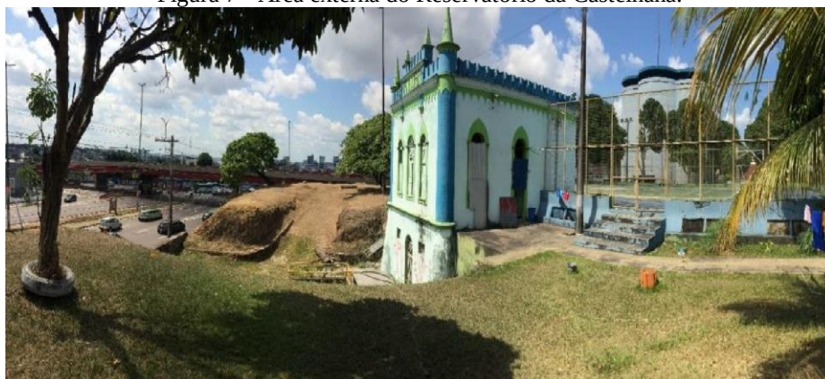
Figura 7 - Área externa do Reservatório da Castelhana.
