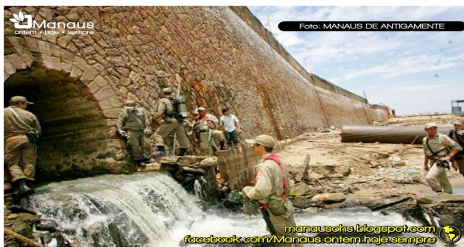
Figura 20: Construção de galerias no Igarapé
