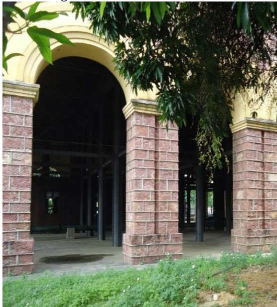
Figura 9 - Reservatório do Mocó 2
