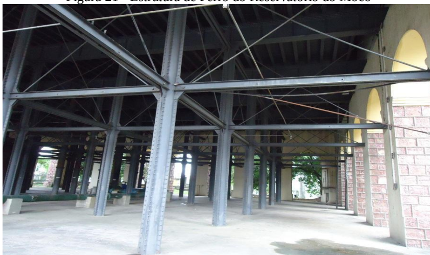
Figura 21 - Estrutura de Ferro do Reservatório do Mocó
