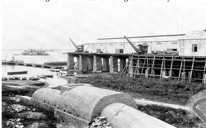
Figura 11 - Emissário de Esgoto -Roadway
