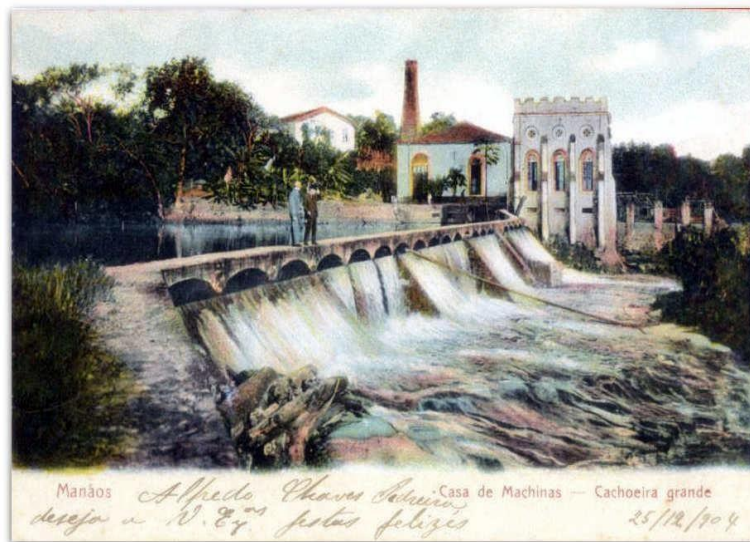
Figura 2 - Hidrelétrica da Cachoeira Grande- 1904
