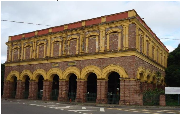
Figura 8 - Reservatório do Mocó
