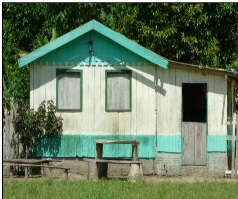
Figura 08 – Casa de madeira da comunidade Nossa Senhora do Bom Parto
