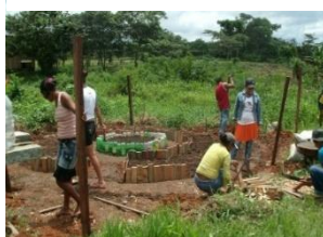
Figura 32 - Construção da horta mandala
