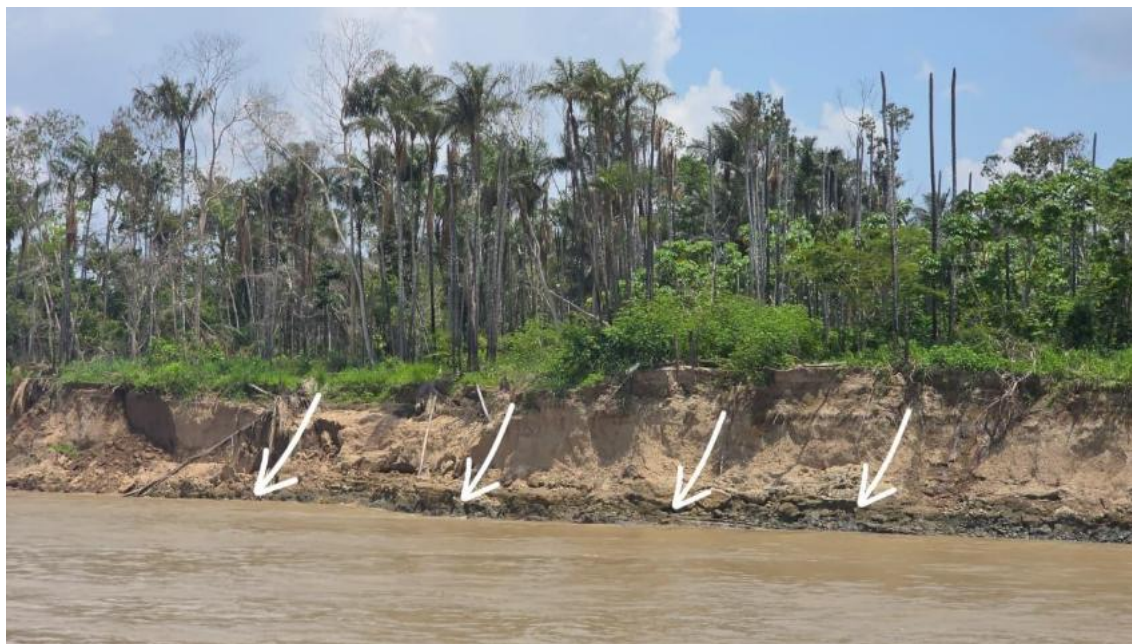
Figura 44. Terras caídas na margem da área de estudo.
