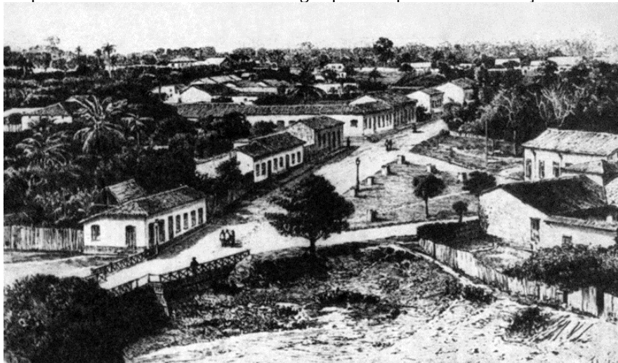
Figura 3 - Vista parcial de Manaus – Ponte sobre o Igarapé do Espírito Santo e Praça Riachuelo - 1872-1884
