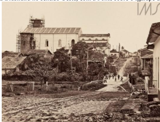
Figura 7 - Vista da rua Brasileira no sentido Oeste, com a Ponte sobre o Igarapé do Espírito Santo, 1865.
