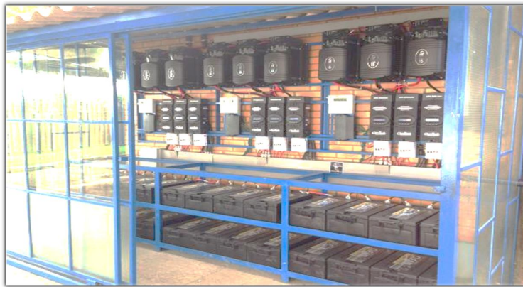
Figura 36. Sala de controle do Sistema Fotovoltaico do LACTEC na UFPR.
