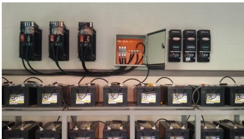
Figura 73. Início das conexões com os inversores.
