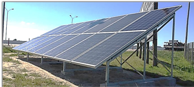
Figura 34. Exemplo de painéis solares instalados em suporte metálico.
