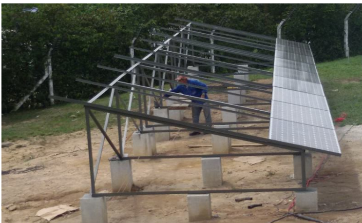
Figura 62. Vista lateral dos suportes metálicos e instalação da 1ª fileira de painéis.
