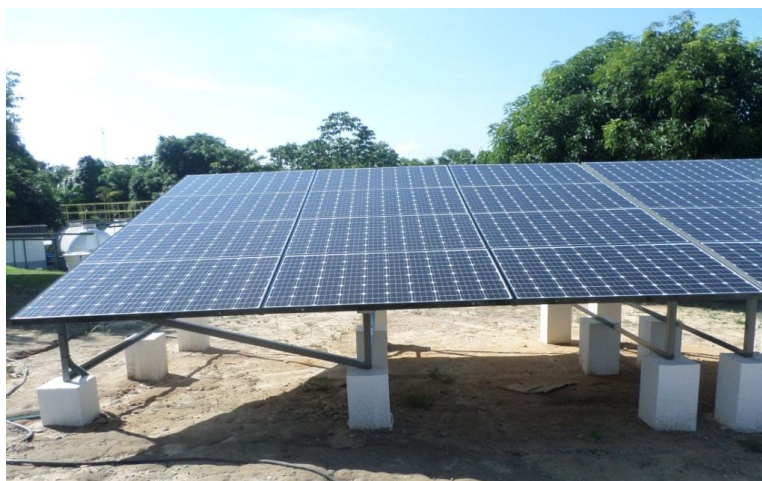
Figura 63. Configuração da montagem de um bloco gerador de painéis fotovoltaicos.
