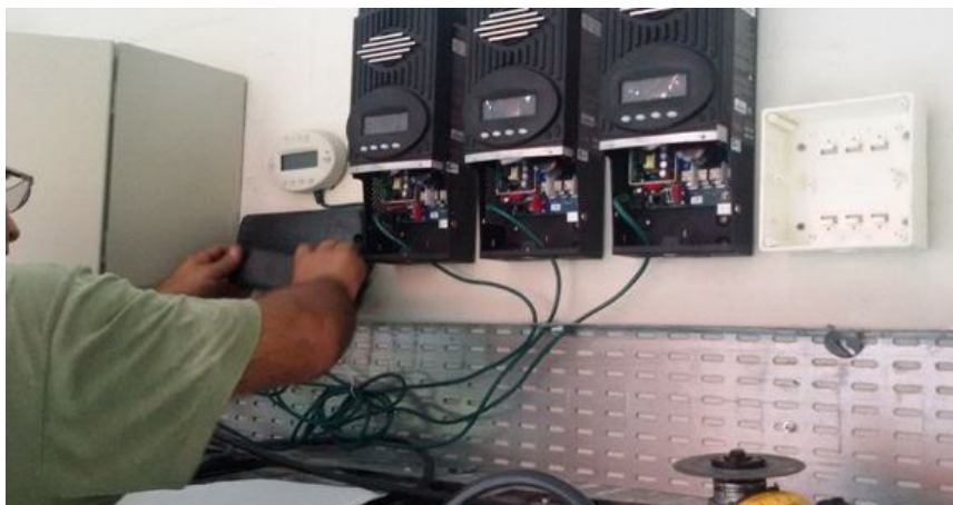
Figura 74. Instalação dos condutores de comunicação de dados.
