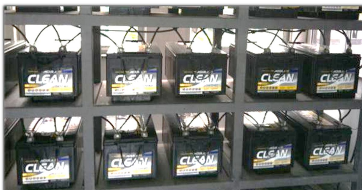
Figura 32. Banco de acumuladores em um sistema fotovoltaico.
