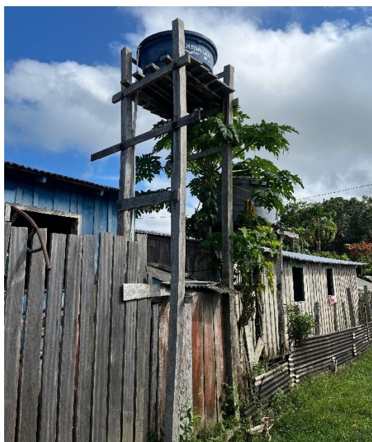
Figura 38 - Caixa d'água abastecida diretamente pelo poço artesiano da comunidade Cristo Rei
