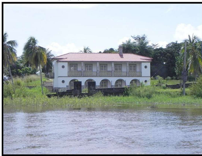
Figura 06 – Casa de J.G. Araújo em Vila Amazônia – construída em 1950/1951
