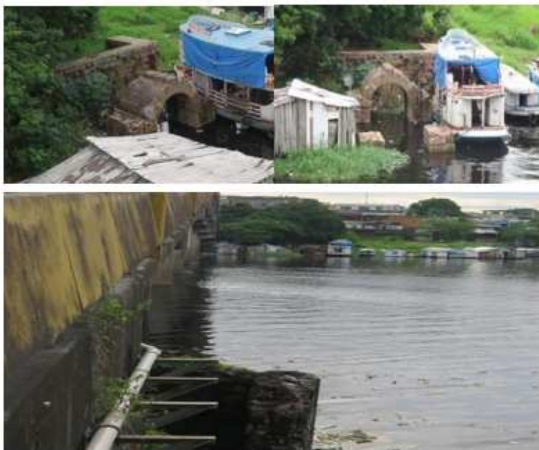
Figura 13 - De cima para baixo – As duas primeiras mostram a estrutura em perspectiva de cima da ponte atual – A terceira mostra a partir da outra margem em primeiro plano uma coluna do mesmo período e ao fundo a estrutura.
