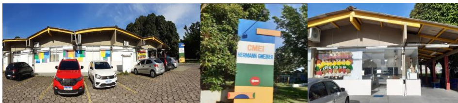
Figura 2 - Fotografias: Fachada do CMEI Hermann Gmeiner nas dependências atuais
