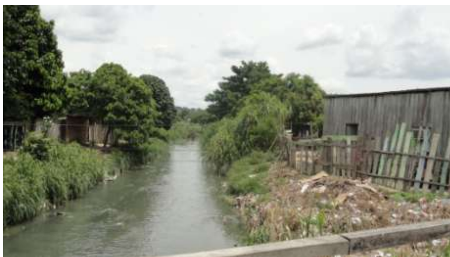
Figura 03. Rua Baleia, observa-se a construção de residências em áreas de APP sujeita a alagação.
