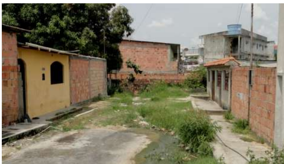
Figura 08. Rua Carlos Braga, observa-se os lotes sem tamanhos e limites adequados.
