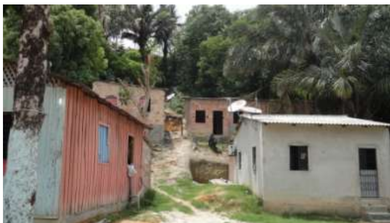
Figura 05. Rua Tamuatá, observa-se a construção de residências em áreas de encosta com declividade acentuada e risco de processo erosivo.
