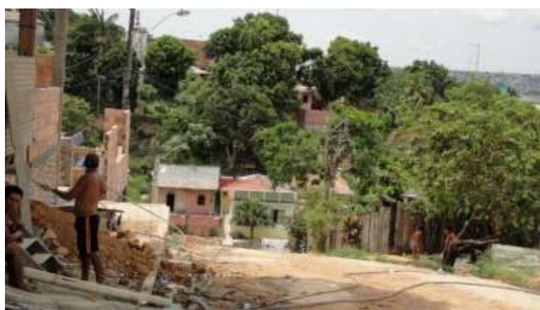
Figura 06. Rua Arapapá, observa-se o risco de processo erosivo
