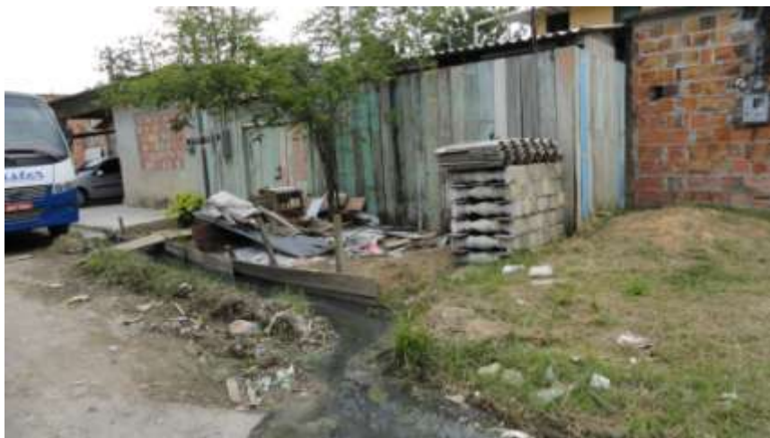
Figura 12. Beco Bom Jesus, observa-se o lançamento de esgoto em via pública.
