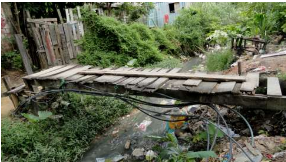
Figura 11. Beco Bom Jesus, observa-se o abastecimento irregular de água no local de estudo.
