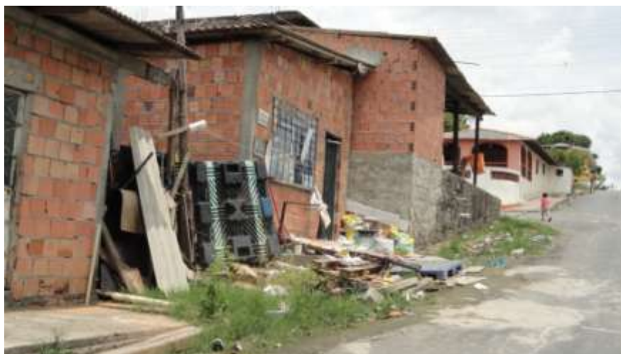
Figura 07. Rua Mapará, observa-se a estrutura dos imóveis e ou lotamentos com edificações desprodonizadas.
