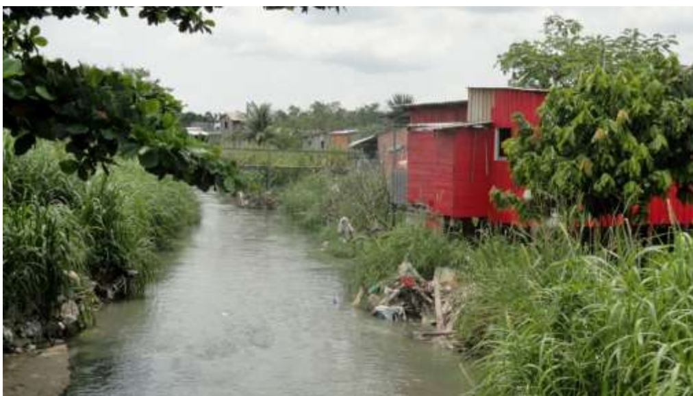
Figura 04. Rua I, observa-se a construção de residências em áreas de APP sujeita a alagação
