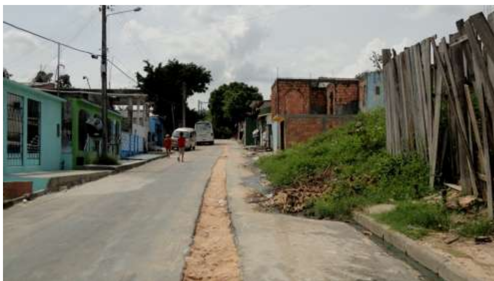
Figura 05. Rua Aruanã, observa-se o esgoto em via pública
