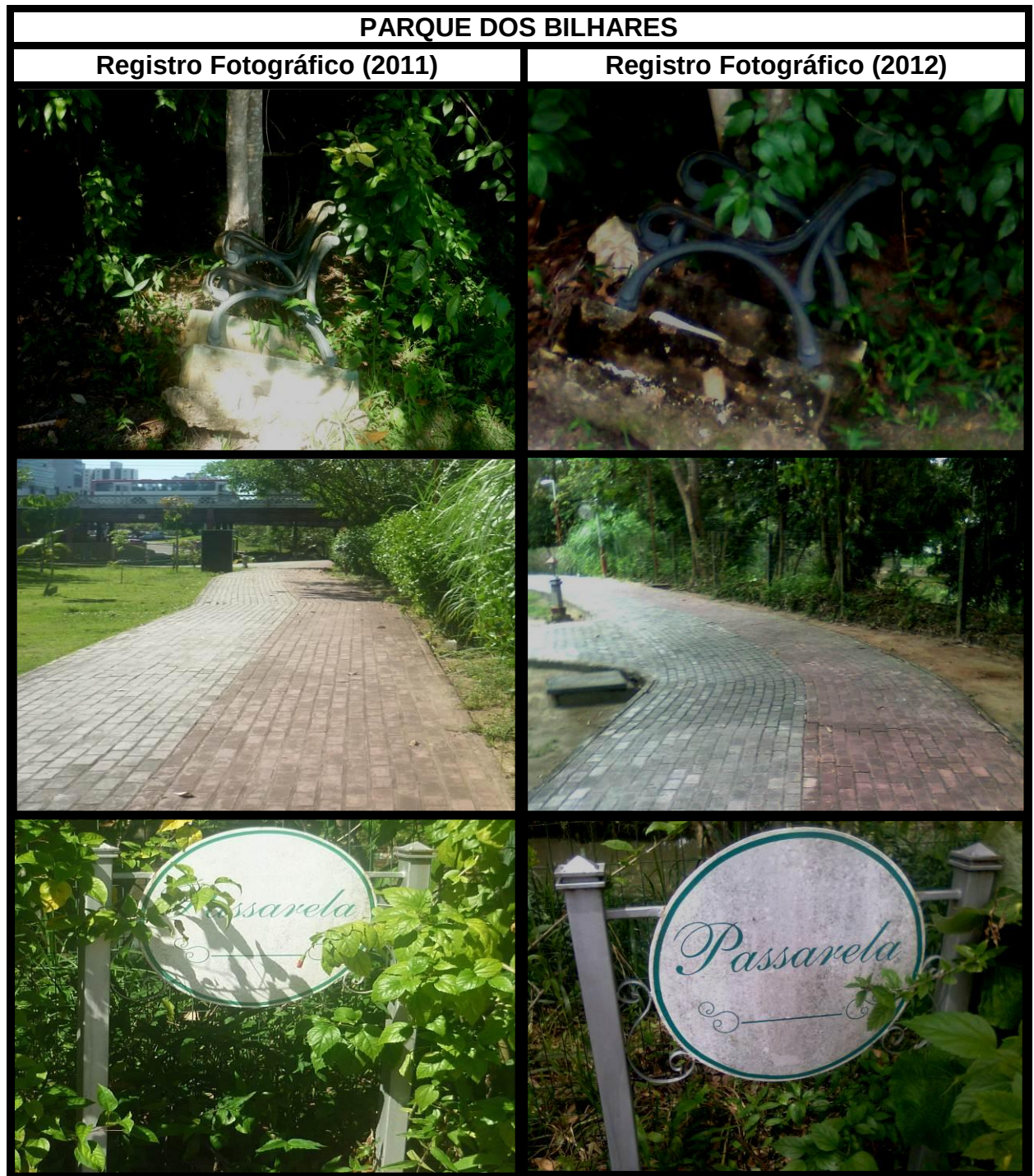
FIGURA 21: Processo de Deterioração do Parque dos Bilhares.
