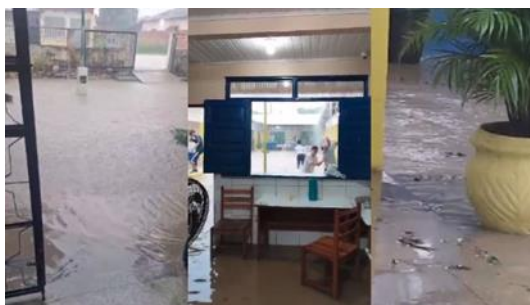
Figura 2 - Escola Estadual Irmã Sá após chuva intensa
