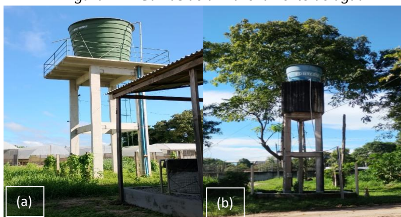
Figura 24 - Caixas de armazenamento de água
