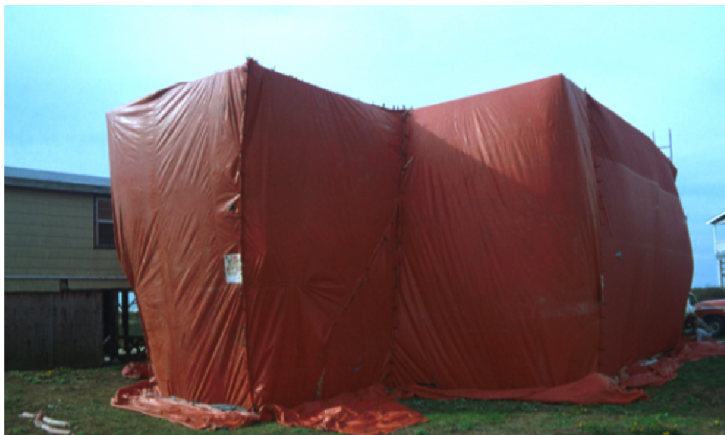
Figura 16- Uma casa coberta com lona para aplicação de gás ( H_3Br ) contra cupins de madeira-seca.
