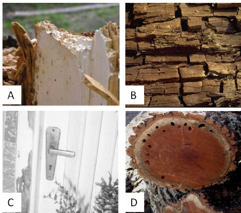
Figura 6- Peças de madeira biodegradadas por fungos e cupins: A- Fungo de podridão branca; B- Fungo de podridão parda; C- Cupins de madeira-seca; D- Coleópteros.
