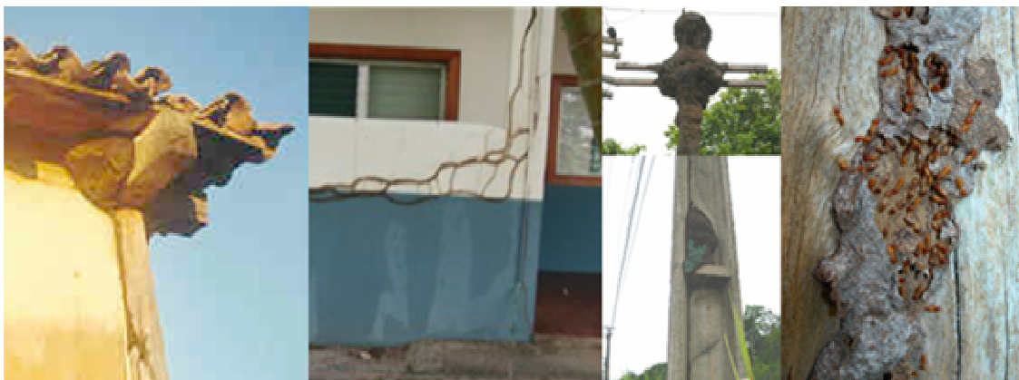
Figura 12- Infestação de Nasutitermes sp. em edificações. Fonte: CUPINS EM HABITAÇÕES, acessado em 2007; Issa (2007); Pierrot (2007).
