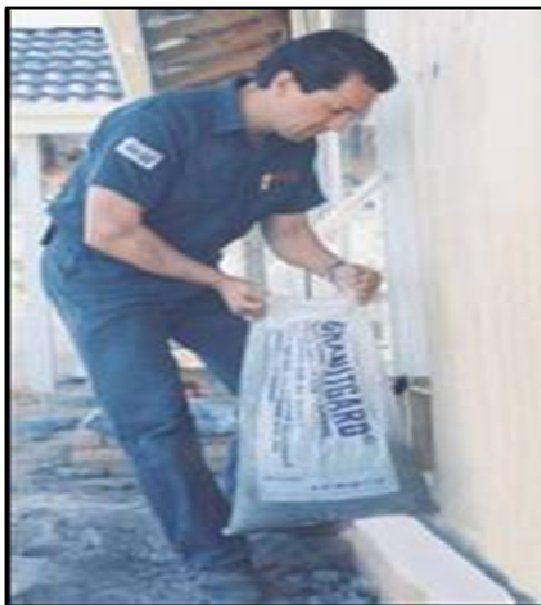
Figura 22- Aplicação do Granitgard em torno de uma residência. Fonte: CSIRO (2007).
