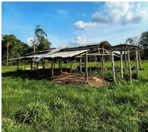
Figura 22 - Estrutura Coberta para acúmulo de Dejetos
