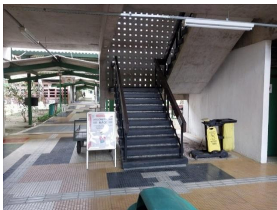
Figura 2 - Escada de acesso à Sala da Coordenação do PPGAS/Setor Norte
