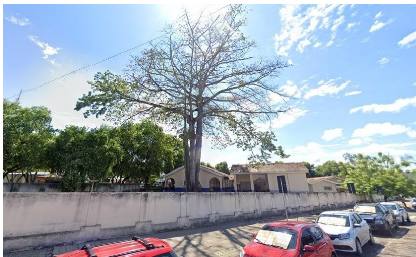
Figura 4 – Parte externa do prédio da Divisão de Educação Especial
