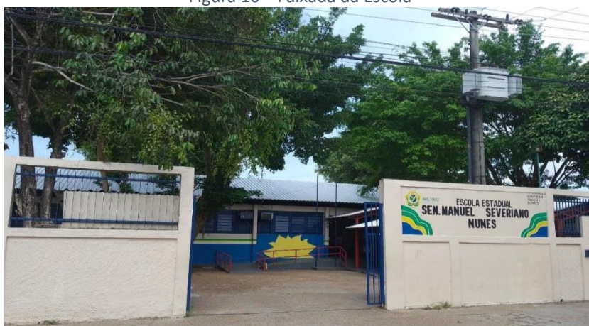
Figura 16 – Faixada da Escola
