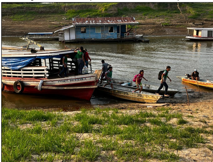
Figura 10 - Desembarque escolar sem estrutura adequada
