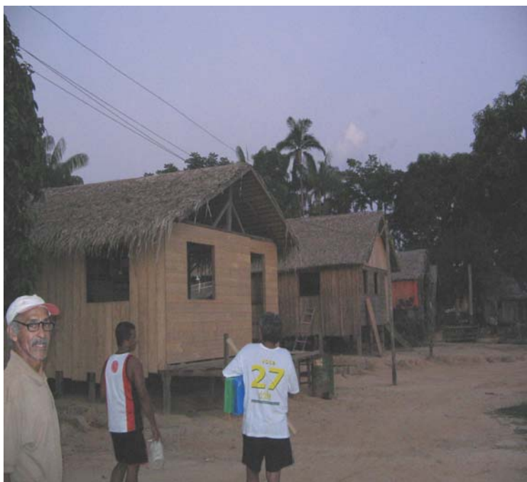
Figura 3, comunidade Nossa Senhora De Livramento moradias construídas na terra com telhado de palha.
