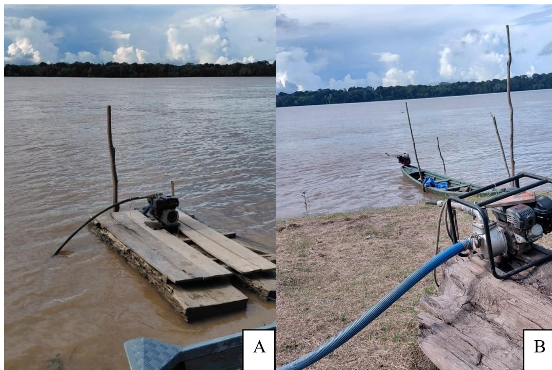
Figura 8 – Sistema de bombeamento de água, utilizado pela comunidade
