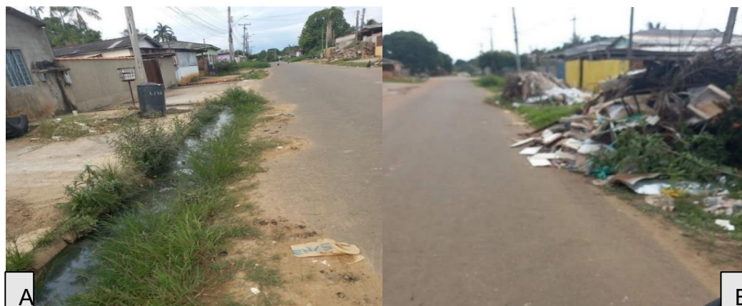
Figura 19: Esgoto a céu aberto no bairro São Cristóvão imagens A e entulho B.
