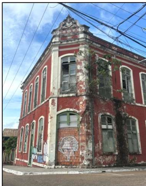
Figura 17: Situação de conservação do prédio histórico
