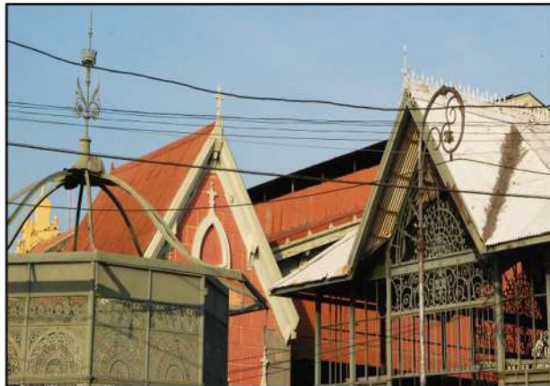
Figura 10: Pavilhão do Mercado
