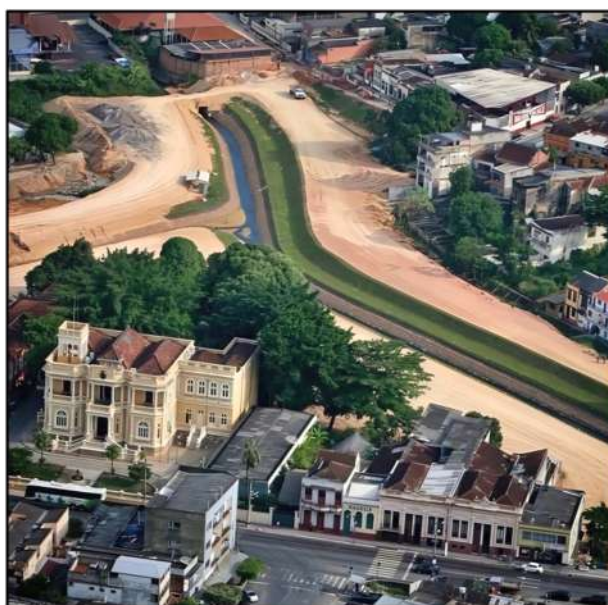
Figura 45: Construção do Parque Jefferson Péres.
