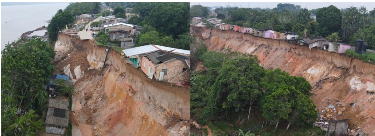
Figura 02 - Rua Dom José Lourenço, após o deslizamento de terra (vista aérea).
