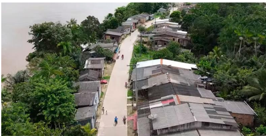
Figura 01 - Rua Dom José Loureço, antes do deslizamento de terra.
