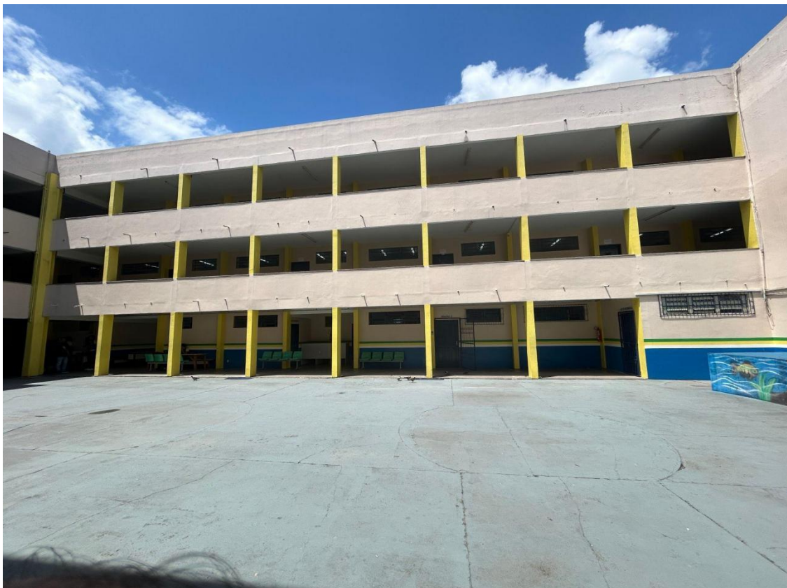
Imagem 2: Parte dos andares e do térreo da escola. (Foto nossa.)
