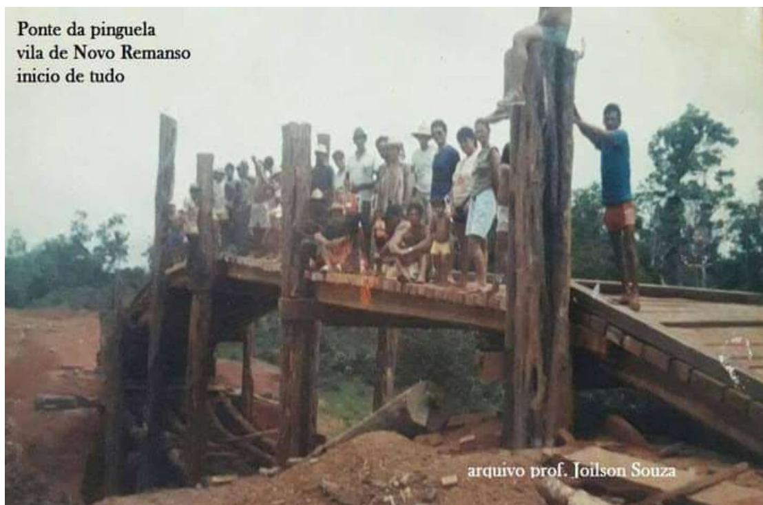
Figura 30: Estrada de Novo Remanso em construção – Ponte da Pinguela
