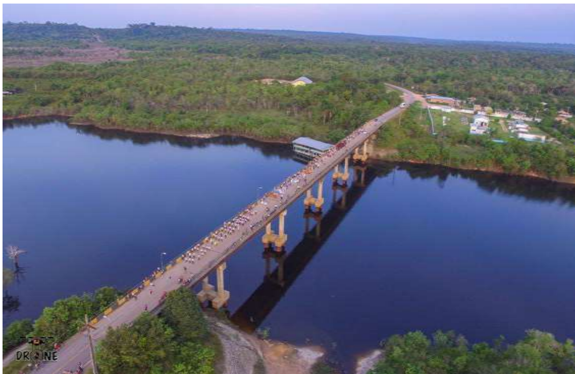
Figura 28: Ponte sobre o Rio urubu
