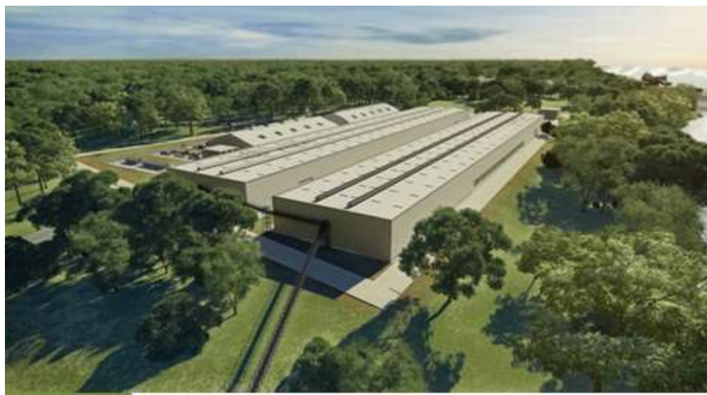
Figura 39: Estruturas de armazenagem do TGSM
