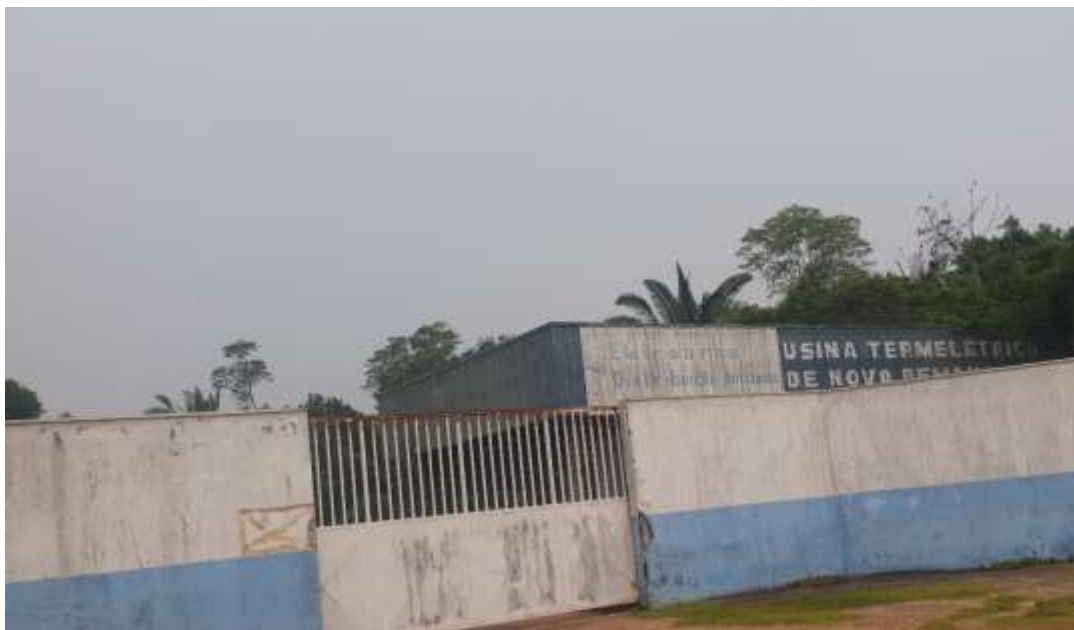
Figura 31: Usina Termelétrica de Novo Remanso
