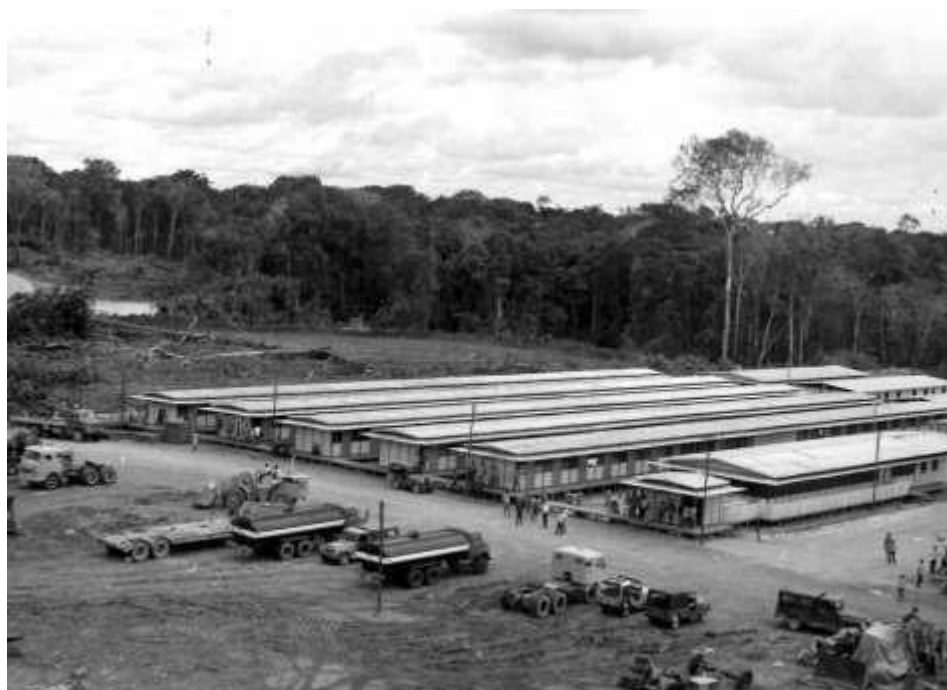
Figura 2: Alojamento de trabalhadores da Construtora Andrade Gutierrez na BR-319
