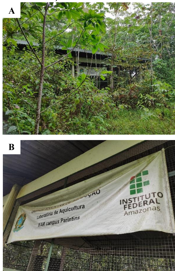
Figura 22 – A) Laboratório de Aquicultura do IFAM abandonado. B) Fachada do Laboratório de Aquicultura do IFAM Parintins. Fonte: este trabalho, 2025.
