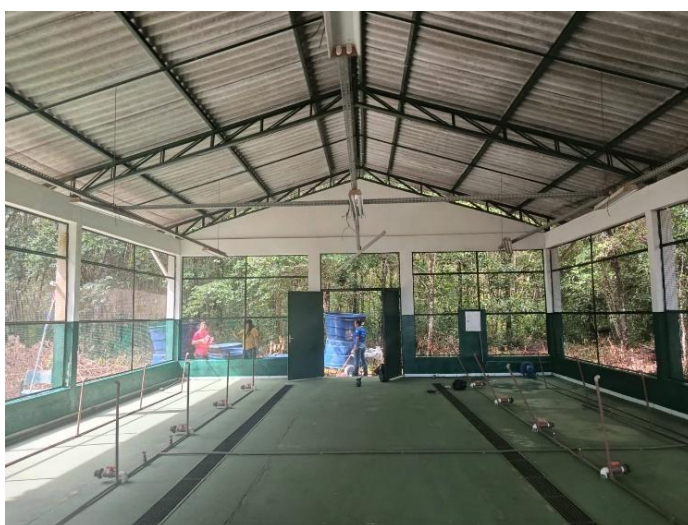
Figura 26 – Vista interna do Laboratório de Aquicultura do IFAM após limpeza. Fonte: Oliveira, 2025.
