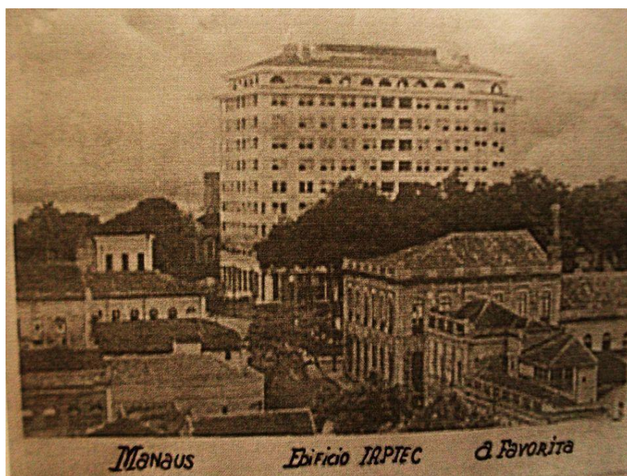
Figura 26: Edifício IAPETEC em postal dos anos 1950
